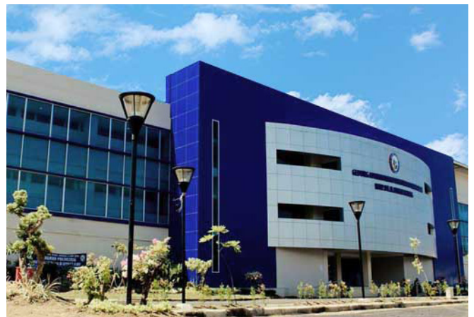
RSUD Dr. M. Djamil Padang Isolation Transformer
