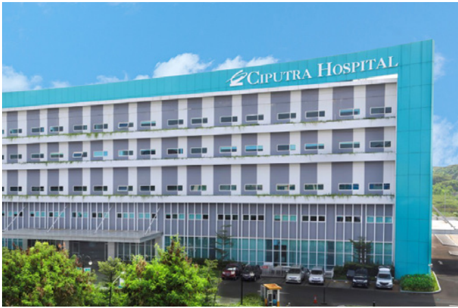
Ciputra Hospital Jakarta
