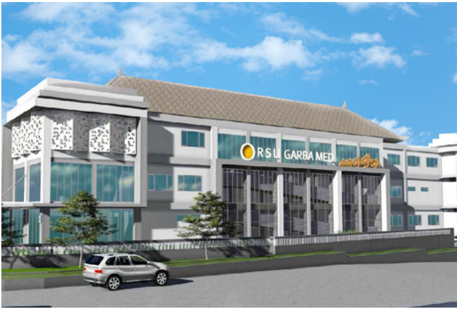
RSU. GarbaMed Kerobokan, Bali
